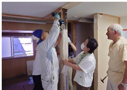
浴室修繕作業の様子
