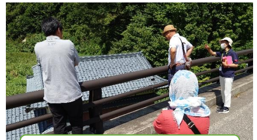
2階部分まで土砂に埋もれた家
